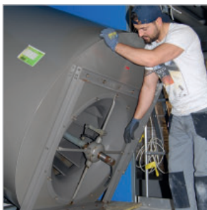
L'ancien ventilateur est démonté et ...
